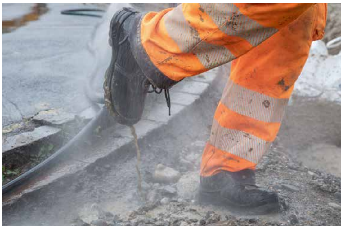
Tücken des Flüssigbodens: Der Baustoff spritzt beim Hineinleeren auch neben den Graben.
