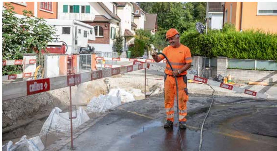
Tücken des Flüssigbodens: Der Baustoff spritzt beim Hineinleeren auch neben den Graben.
